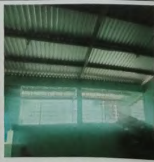
Foto 5: Vista de MODULO A cambio de cubierta de lamina de zinc por lamina troquelada cal 26. Mantenimiento de balcones de metal.
