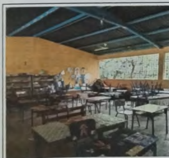
Foto 3: Vista de MODULO A cambio de cubierta de lamina de zinc por lamina troquelada cal 26
