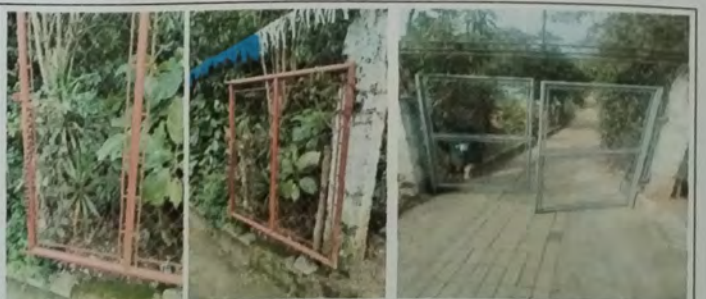
Foto 18: VISTA de porton sustitucion de puerta de metal que esta al ingreso sobre la calle principal.
