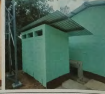
Foto 12: VISTA MODULO D servicio sanitario, cambio de cubiera de estructura de madera por estructura de metal así mismo se cambio la cubierta de lámina de zinc por lámina troquelada cal 26. + pintura en muros.
