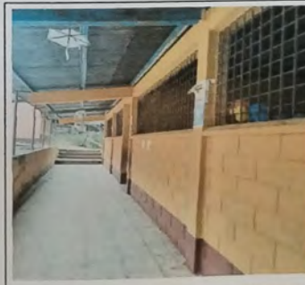
Foto 4: Vista de MODULO A cambio de cubierta de lamina de zinc por lamina troquelada cal 26. Mantenimiento de balcones de metal.
