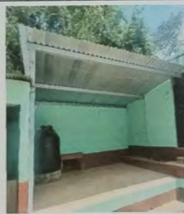
Foto 9: VISTA DE ESCENARIO cambio de cubierta de lámina de zinc por lámina troquelada cal 26. + mantenimiento de estructura de metal.
