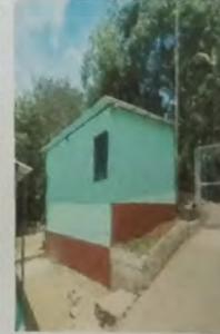
Foto 10: Vista de MODULO C cambio de cubierta de lámina de zinc por lámina troquelada cal 26+ sustitucion de estructura de metal en mal + aplicación de pintura en muros.
