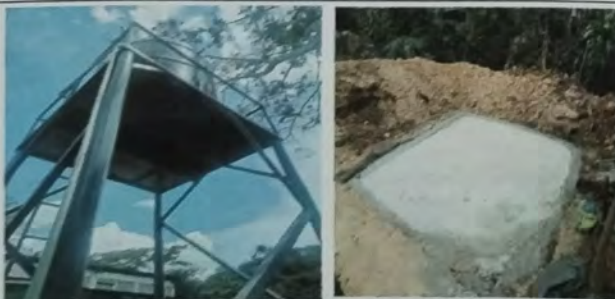
Foto 17: Vista de torre metalica para deposito de agua potable, vista de base de concreto para fosa septica.
