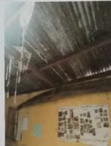
Foto 10: Vista de MODULO C cambio de cubierta de lámina de zinc por lámina troquelada cal 26+ sustitucion de estructura de metal en mal + aplicación de pintura en muros.
