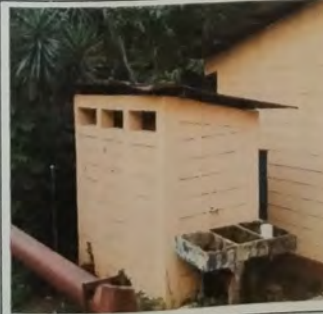
Foto 12: VISTA MODULO D servicio sanitario, cambio de cubiera de estructura de madera por estructura de metal así mismo se cambio la cubierta de lámina de zinc por lámina troquelada cal 26. + pintura en muros.
