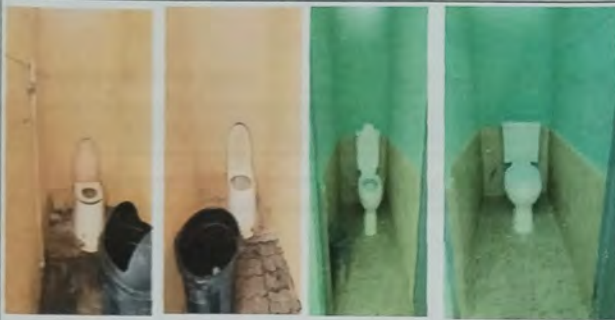
Foto 13: VISTA MODULO D servicios sanitarios , sustitucion de servicios sanitarios + instalacion de azulejo.
