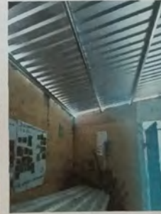
Foto 10: Vista de MODULO C cambio de cubierta de lámina de zinc por lámina troquelada cal 26+ sustitucion de estructura de metal en mal + aplicación de pintura en muros.
