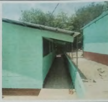
Foto 2: Vista de MODULO A cambio de cubierta de lamina de zinc por lamina troquelada cal 26
