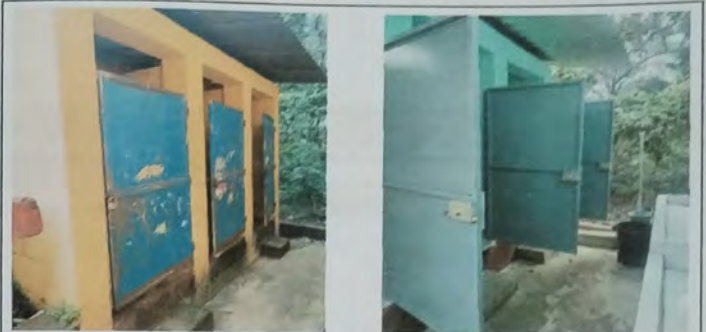
Foto 14: MODULO D servicios sanitario sustitucion de puertas de metal en mal estado
