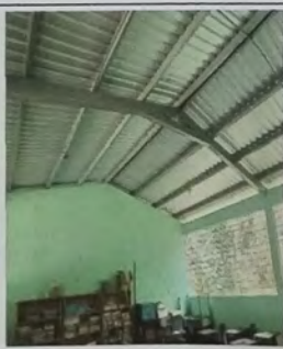
Foto 3: Vista de MODULO A cambio de cubierta de lamina de zinc por lamina troquelada cal 26
