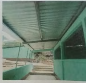
Foto 4: Vista de MODULO A cambio de cubierta de lamina de zinc por lamina troquelada cal 26. Mantenimiento de balcones de metal.
